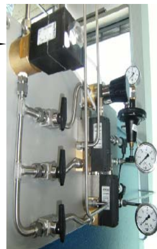
Рис. 3. Узел регулируемой подачи газа
